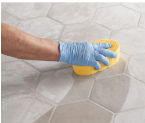
Почистване и заглаждане на фугите с твърда целулозна гъба
